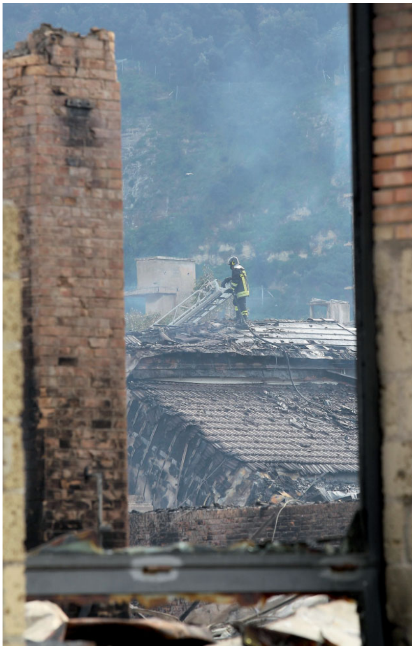
Un particolare della struttura distrutta FOTO LAPRESSE
