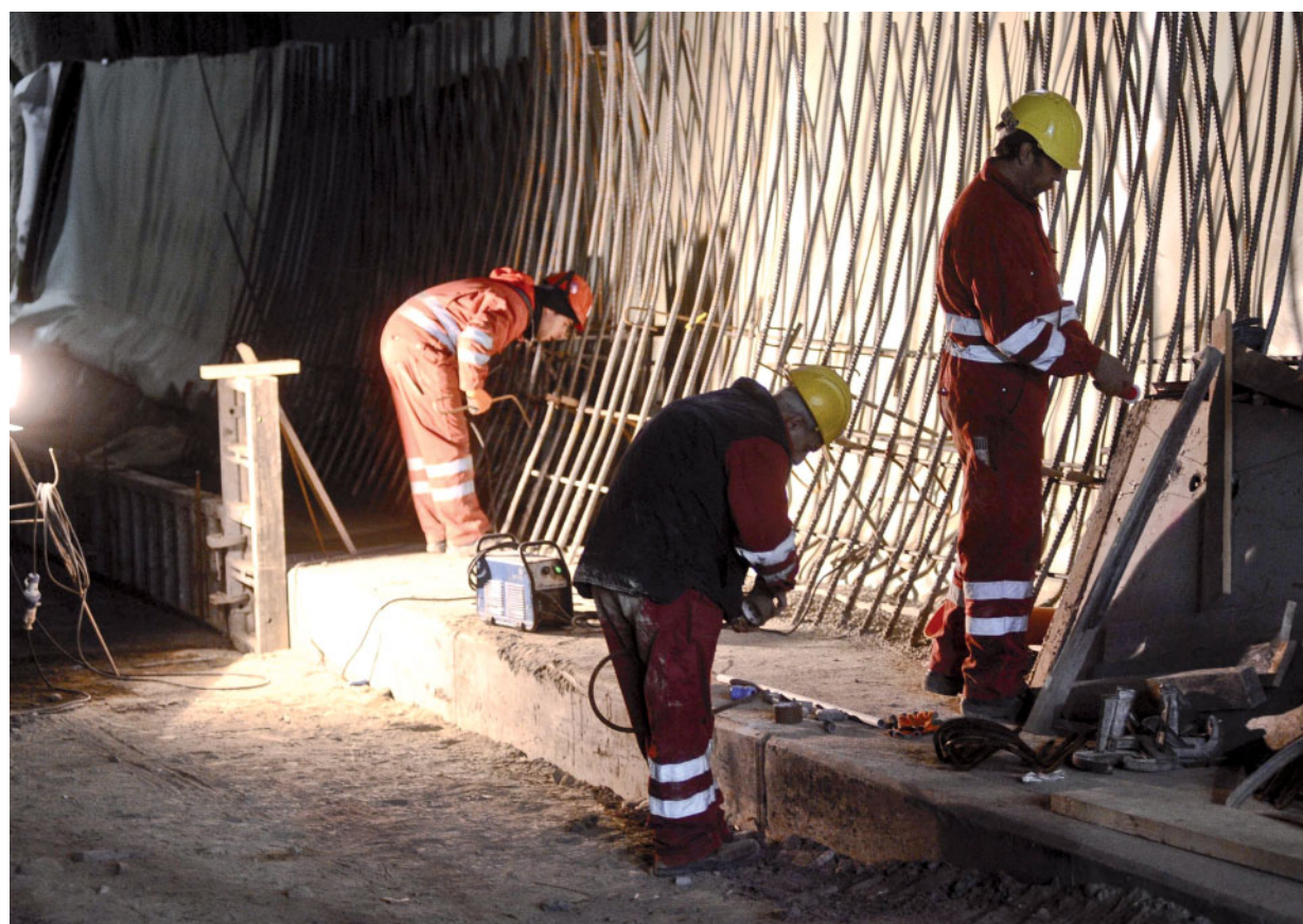
Operai al lavoro in un cantiere FOTO LAPRESSE
