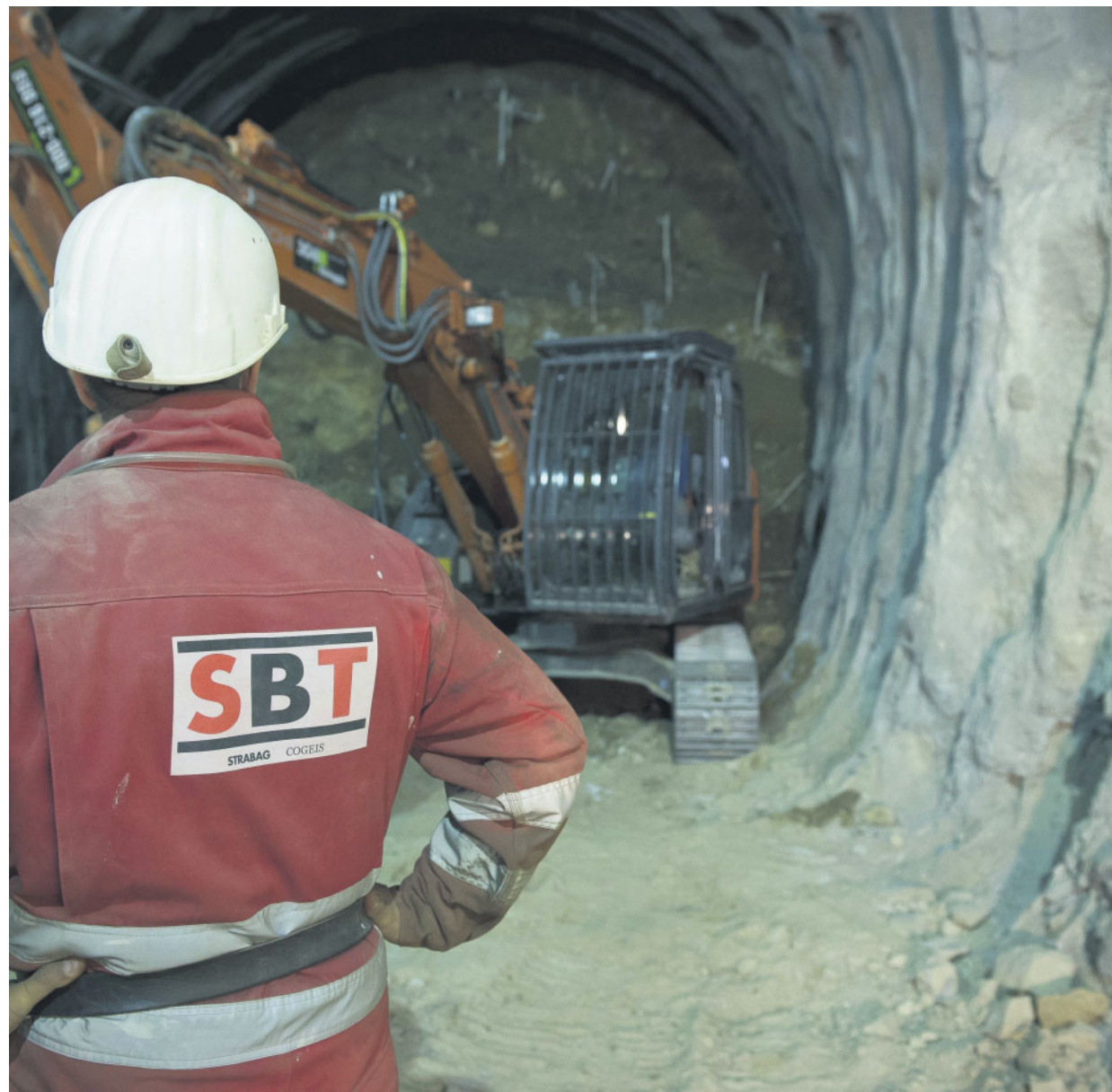
Il cantiere Tav di Chiomonte FOTO LAPRESSE
