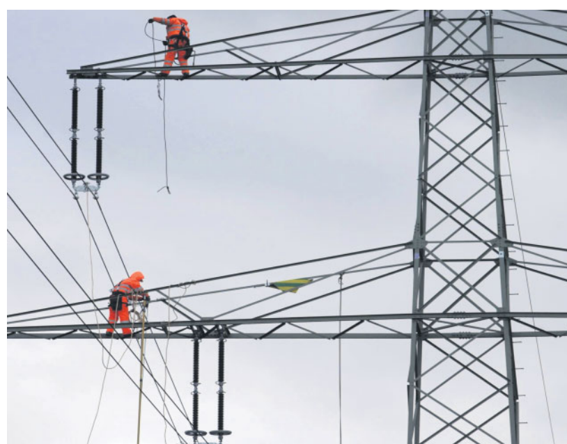
Lavori su un traliccio dell'alta tensione FOTO INFOPHOTO
