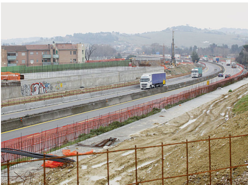
I lavori sull'A14 tra Fano e Cattolica
