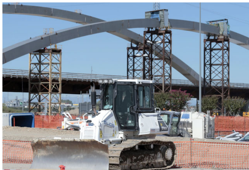
I cantieri Milano Expo 2015 FOTO LAPRESSE
