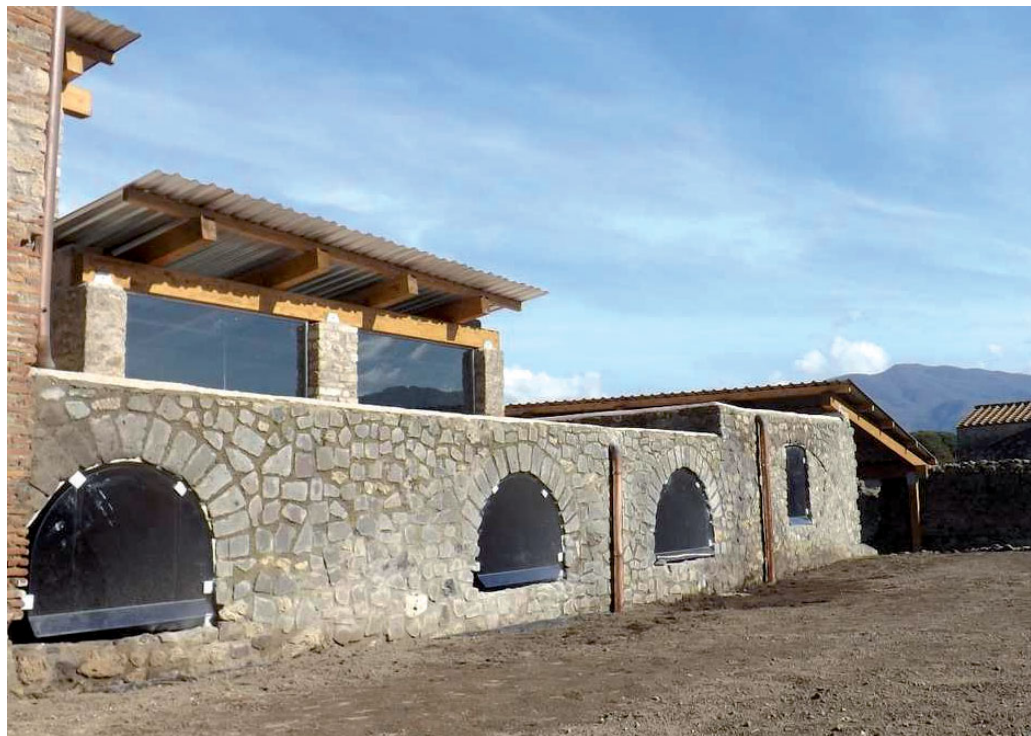
Malte, legno e copertura lamellare
