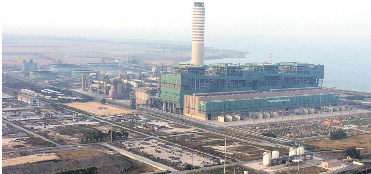
Centrale elettrica Enel di Porto Tolle
