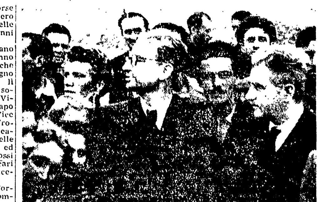
Si piantano i primi pali delle nuove costruzioni. Il compagno D'Onofrio, che tanto si è interessato alle borgate, osserva con soddisfazione l'inizio dei lavori.
