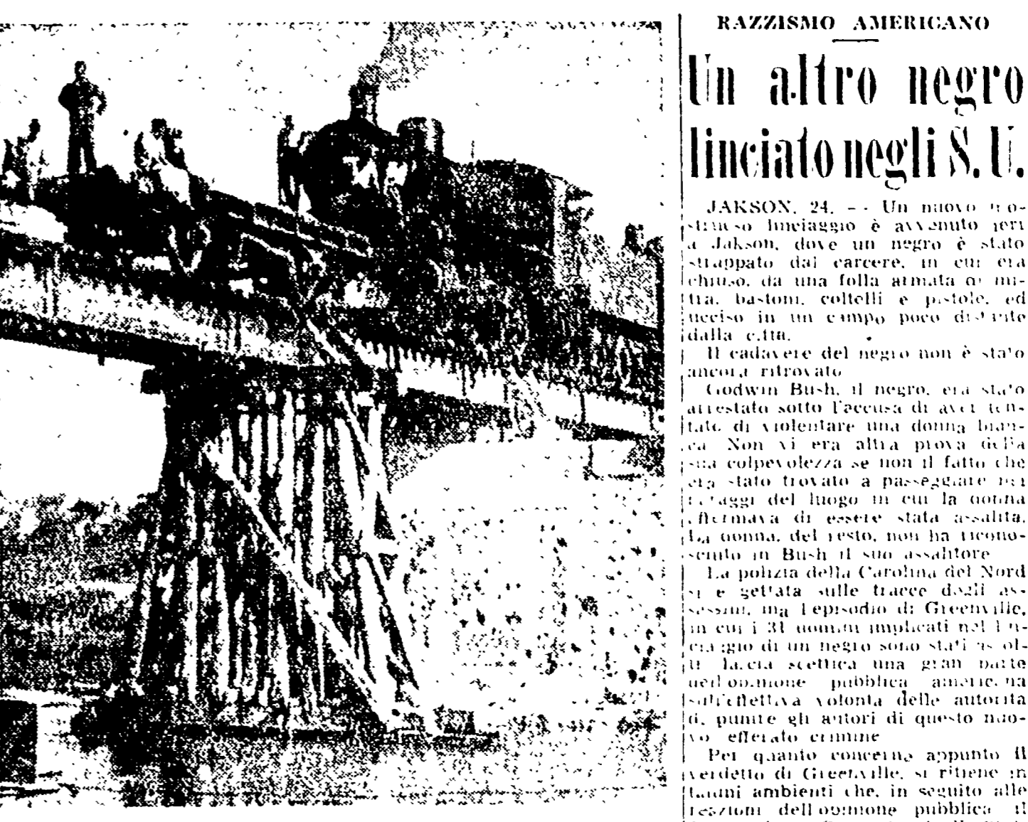
Questo è uno dei 3100 punti ferroviari italiani distrutti dalla guerra. Il capiente è stato ricostruito dai lavoratori della F.I.R. La ripresa dei trasporti, intensissima sotto l'amministrazione del Ministro comunista Giacomo Ferrari, è illustrata nella Mostra della Ricostruzione Ferroviaria, che è stata inaugurata ieri a Roma ai Mercati Trionfali, alla presenza del Capo dello Stato.
