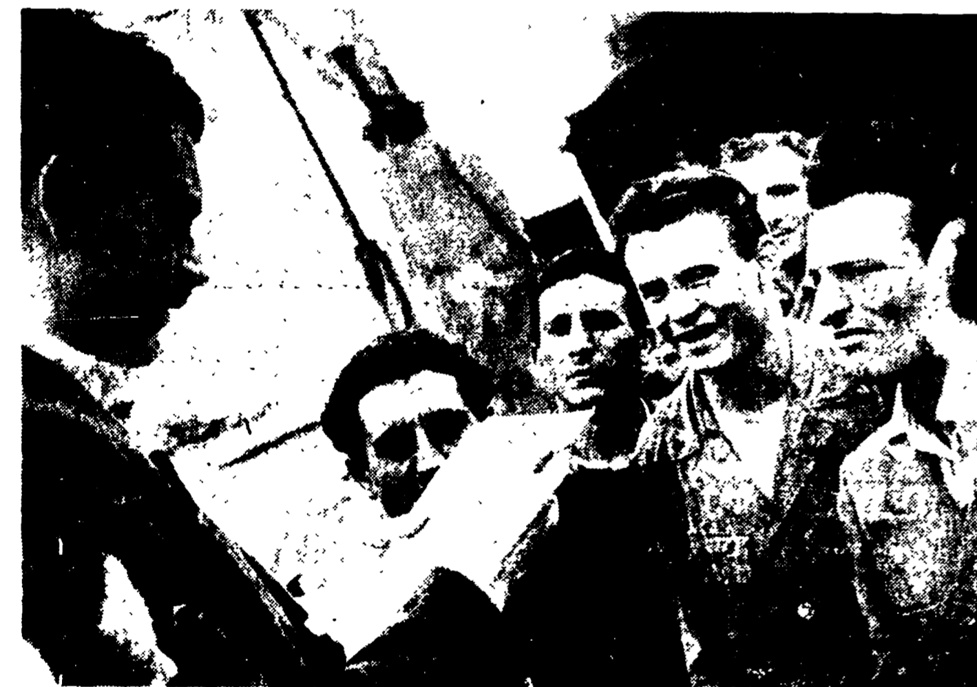
Tutte le mattine la Commissione Interna fa l'appello degli operai del Cantiere
