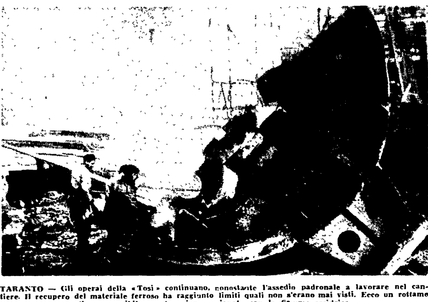
TARANTO — Gli operai della «Tosi» continuano, nonostante l'assedio padronale a lavorare nel cantiere. Il recupero del materiale ferreo ha raggiunto limiti quali non s'erano mai visti. Ecco un rottame il sommergibile mentre viene sezionato con la fiamma ossidrica.
