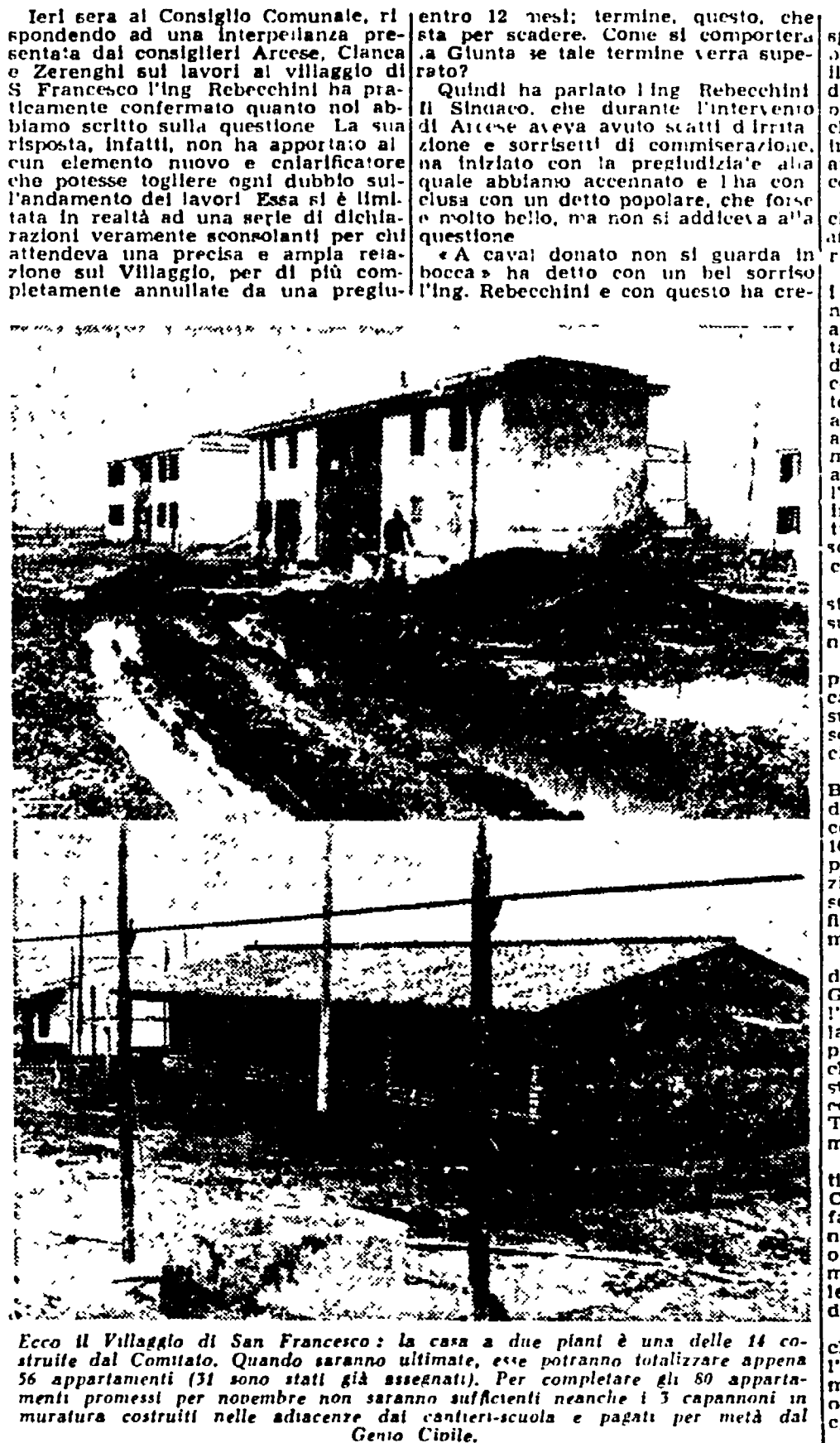
Ecco il Villaggio S. Francesco: la casa a due piani è una delle 14 costruite dal Comune. Quando saranno ultimate, esse potranno ospitare 150 appartamenti (31 sono stati già assegnati). Per completare gli 80 appartamenti sufficienti a 200 nuclei di 4 capannoni in muratura costruiti nelle adiacenze dal cantiere-scuola e pagati per metà dal Genio Civile.
