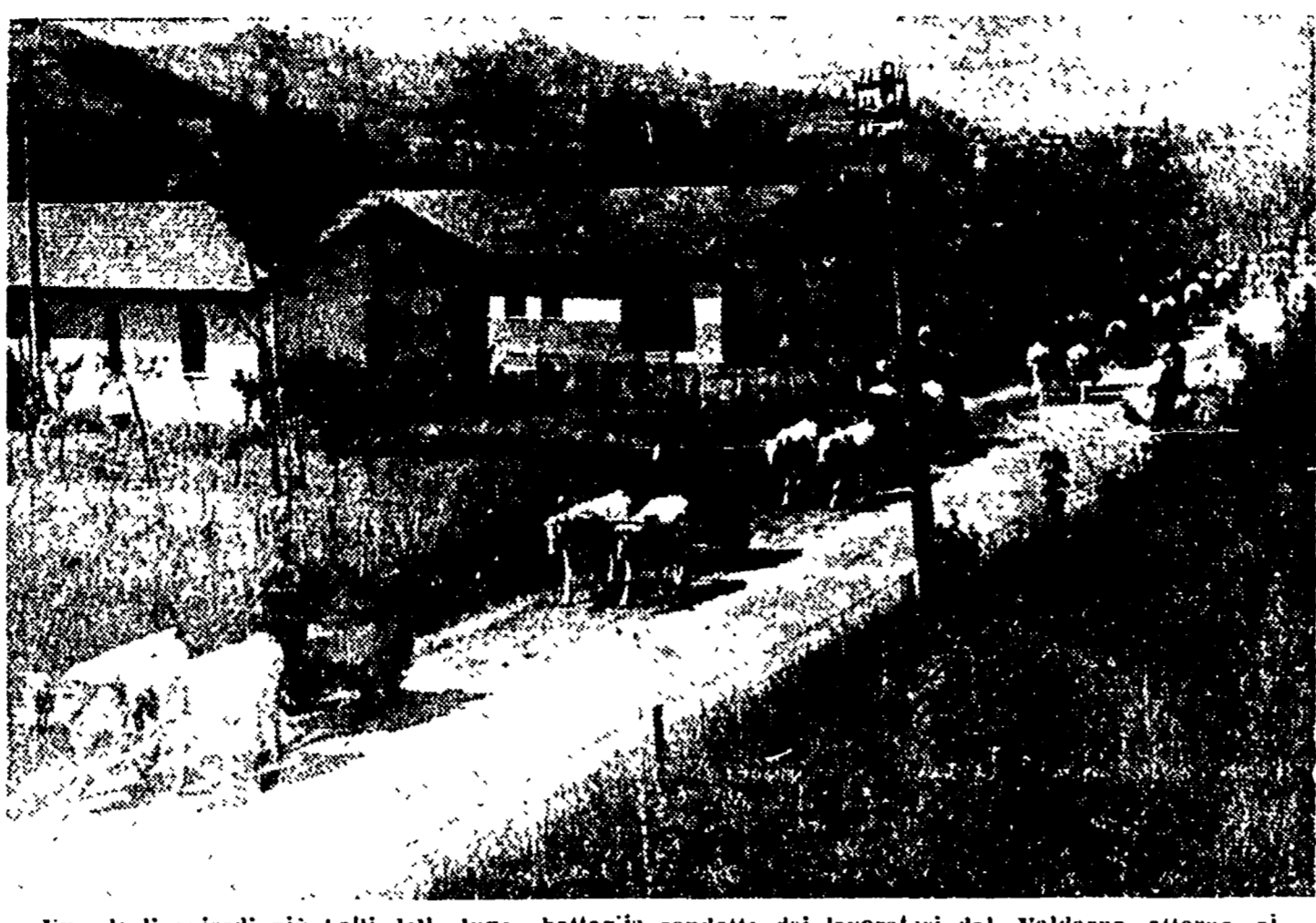
Uno degli episodi più belli della lunga battaglia condotta dai lavoratori del Valdarno attorno ai minatori. Allorché la «Alleanza» ha permesso di trasportare la lignite fino alla ferrovia, i minatori della zona accorsero in aiuto dei minatori. Lunghi file di carri tirati da buoi giunsero dalle campagne e caricarono la lignite di C. elmuovo dei Sabbioni.
