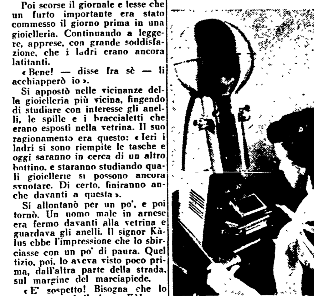
QUESTO MOSTRUOSO apparecchio non è altro che l'ultimo modello di un microscopio elettronico. Sul piccolo rettangolo nero appaiono le immagini dei microbi e dei virus enormemente ingranditi
