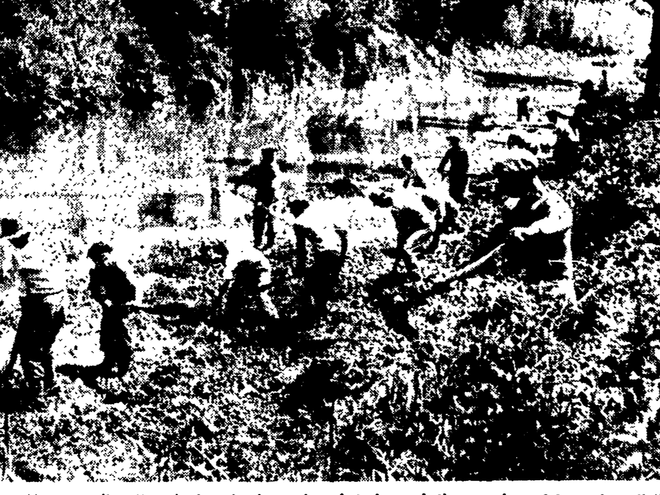
AVEZZANO — Millesettecento braccianti compiono i duri lavori di escavazione del canale collettore nel Fuclino. La lotta per il pane e contro lo sfruttamento di Torlonia continua
