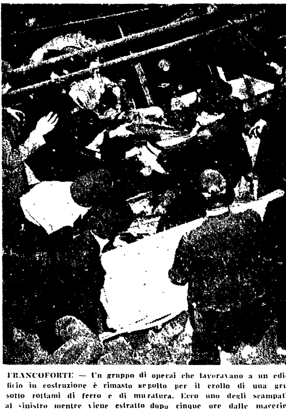
FRANCOFORTE — Un gruppo di operai che lavoravano a un edificio in costruzione è rimasto sepolto per il crollo di una gru sotto rottami di ferro e di muratura. Ecco uno degli scampati al sinistro mentre viene estratto dopo cinque ore dalle macerie
