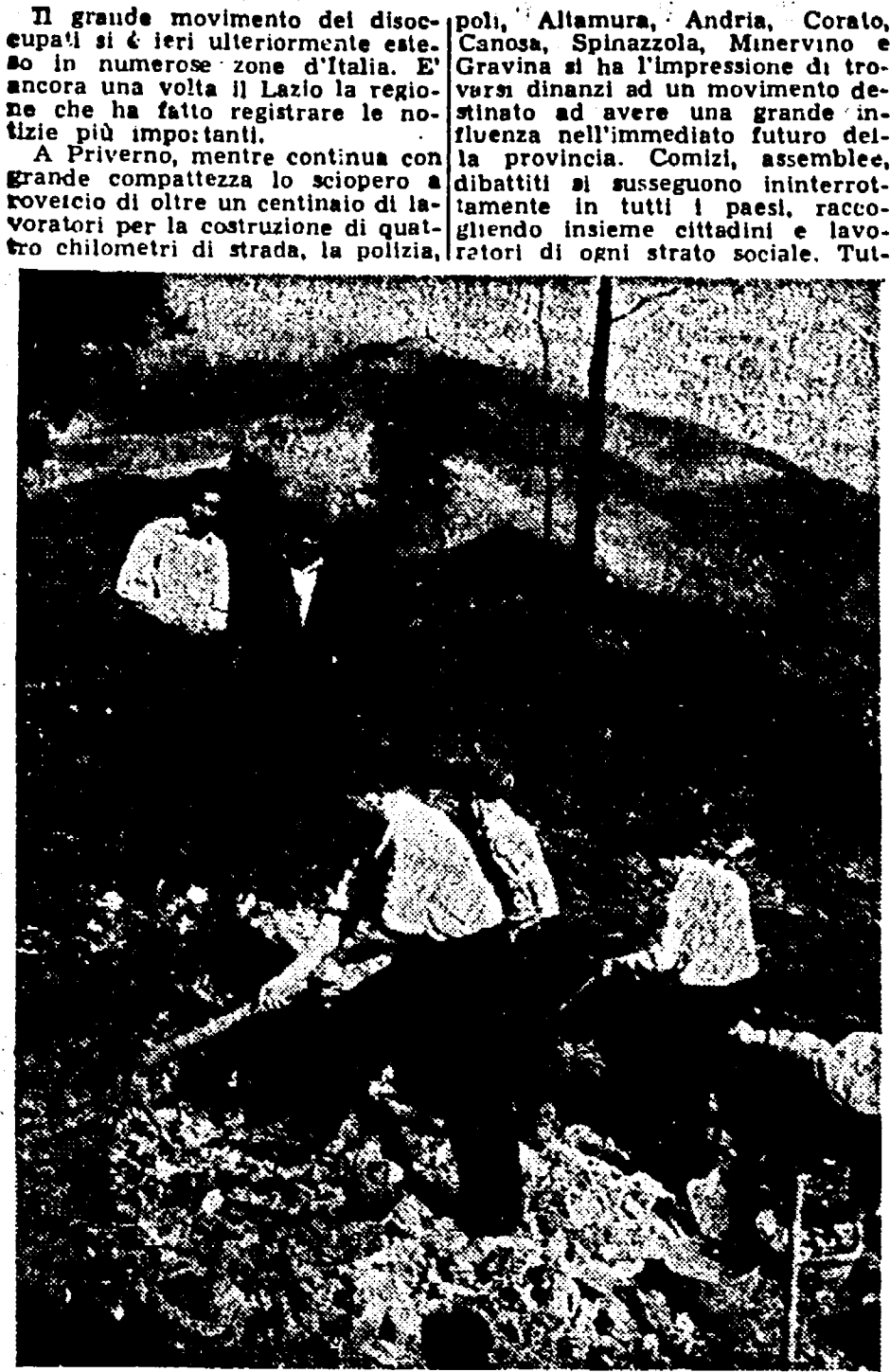
LATINA. 3. - In uno dei quattro scioperi a rovescio in corso nel comune di Sezze gli eredi disoccupati sono impegnati nel faticoso lavoro di costruzione di una strada montana
