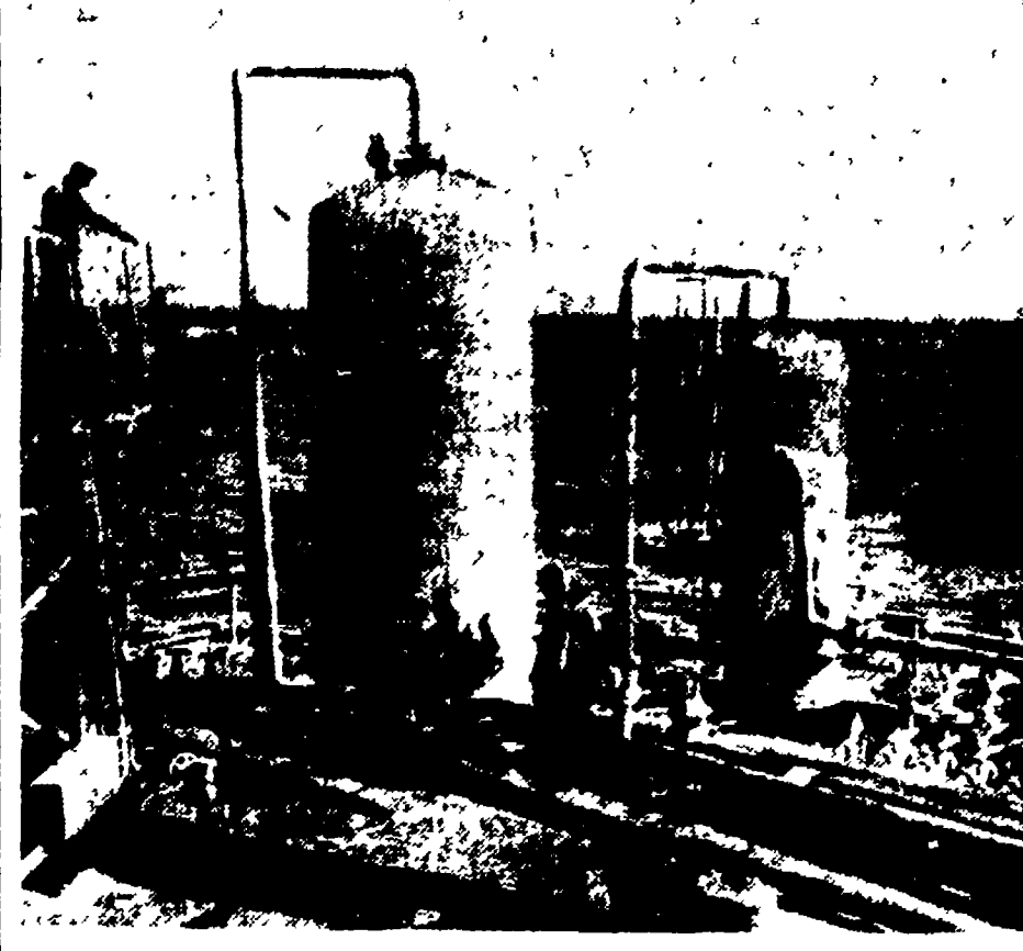
Questi serbatoi, piazzati sull'isola di acciaio, raccolgono dal fondo marino il petrolio che sarà poi riversato nelle navi cisterna
