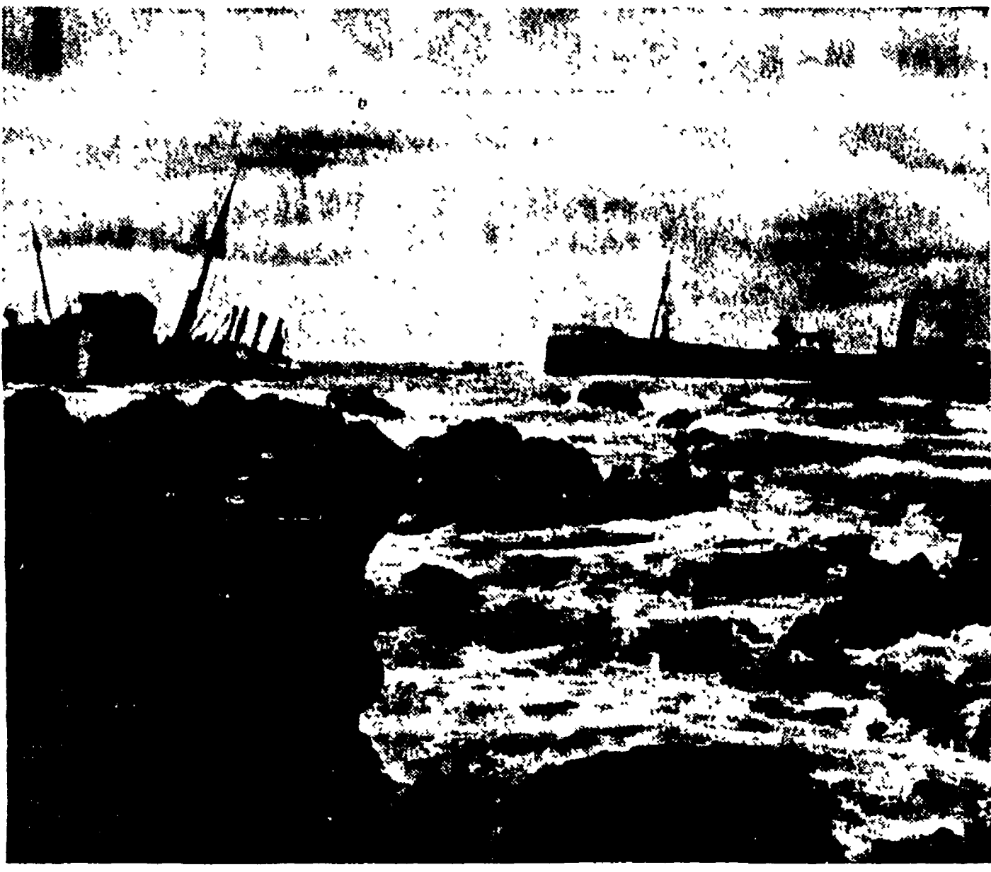
BAKU. I miniatori sovietici, che hanno trovato sorgenti di petrolio sul fondo del mare, al largo del Caspio, hanno affondato vecchie navi per creare una piattaforma artificiale per il lavoro di estrazione. Questa zona ha ricevuto il nome di Isola delle Sette Navi
