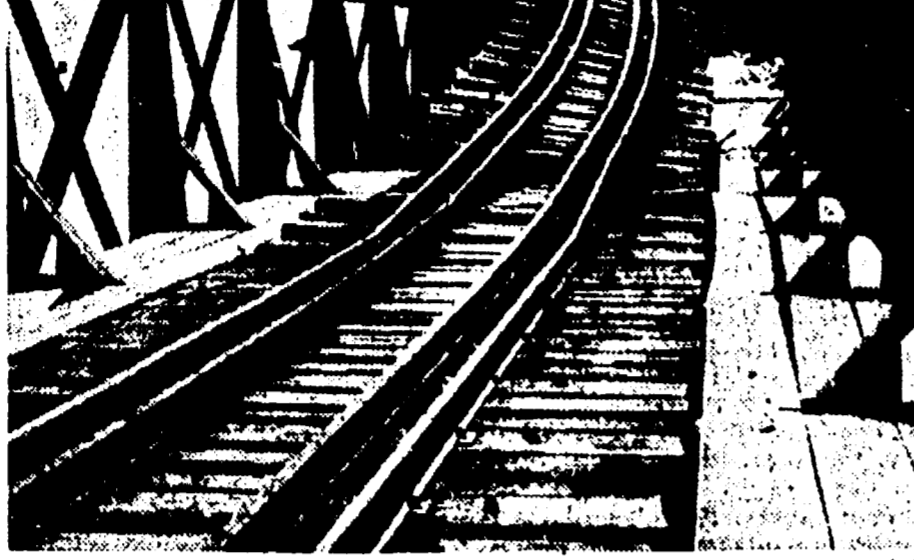
Un'impressionante visione del danno provocato dal malfunzionamento nella zona dell'Alto Lario ai confini con la Svizzera
