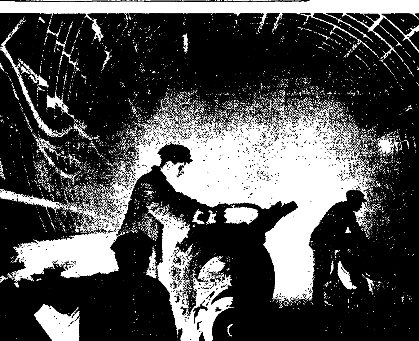
Sotto il corso del Don è in via di realizzazione questo largo tunnel, che rivestirà un importante ruolo nel quadro dei lavori per l'irrigazione di 750.000 ettari di terreno
