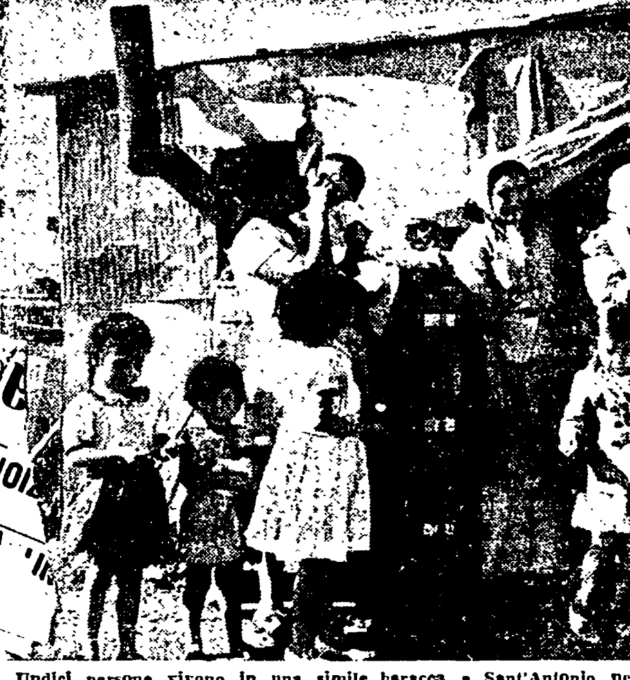
Undici persone vivono in una simile baracca, a Sant'Antonio, nel Texas. Dopo l'inizio dell'aggressione in Corea, Truman ha dimezzato la già esigua somma destinata annualmente alla costruzione di case
