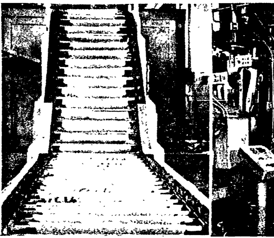
Due fasi di attività della fabbrica: a sinistra, i lingotti vengono avviati automaticamente al forno di fusione; a destra, un operaio mentre osserva il funzionamento di uno dei congegni del forno stesso
