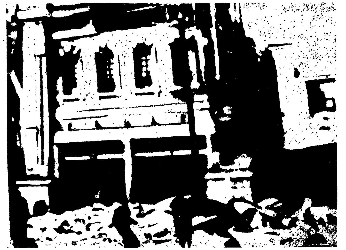
HOKKAIDO - Un drammatico aspetto dell'ospedale Obibito, nell'isola di Hokkaido, gravemente danneggiato dal tremendo movimento tellurico di questi giorni - (Radiofoto)
