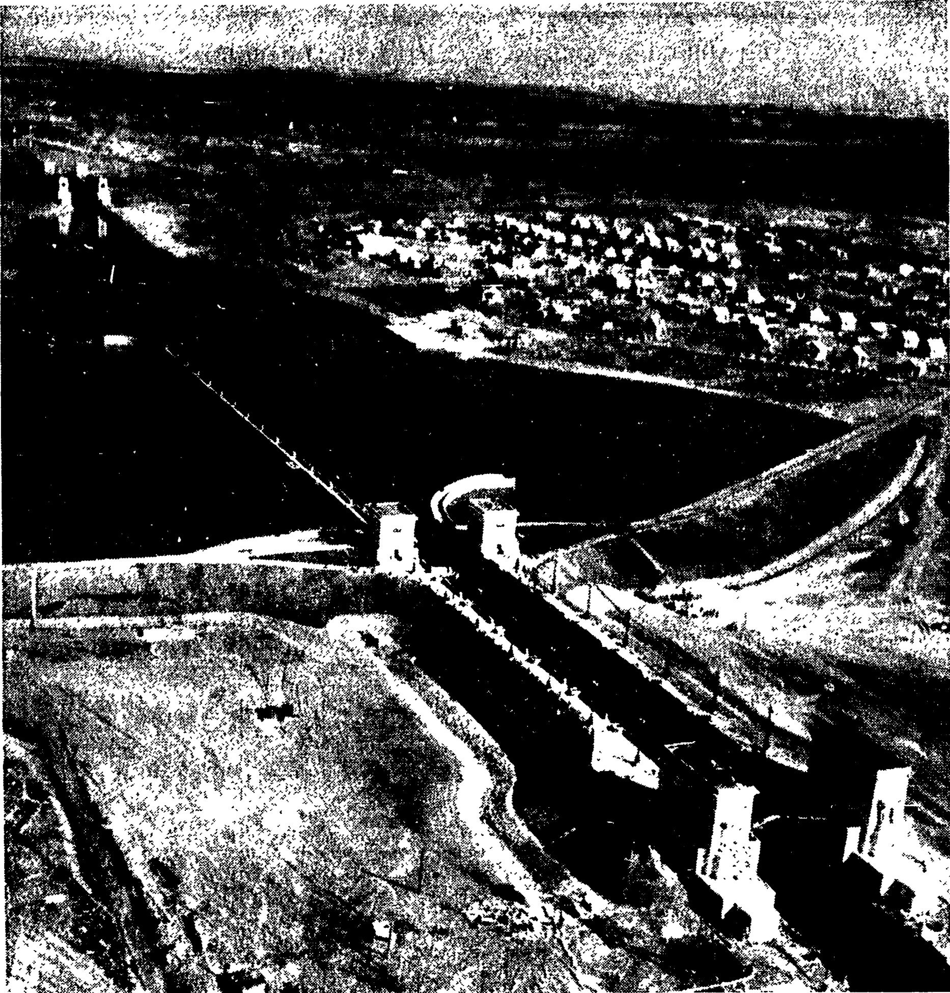
Ecco una serie di foto dalle quali appare particolarmente chiaro il funzionamento del grande canale che congiunge il Volga con il Don. La prima fotografia (sopra) mostra una veduta di due chiuse (la 7, e l'8.) della cosiddetta scala del Volga, attraverso la quale i battelli possono salire dal livello del Volga fino allo spartiacque di Ergheminsk, ad una altezza di 88 metri superiore. La seconda foto (di fianco) mostra in primo piano la chiusa numero otto e nello sfondo quella che porta il numero nove.
