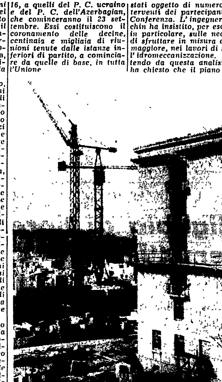
LENINGRADO - Costruzione di edifici a mezzo di grandi pannelli prefabbricati, in via Stalin
