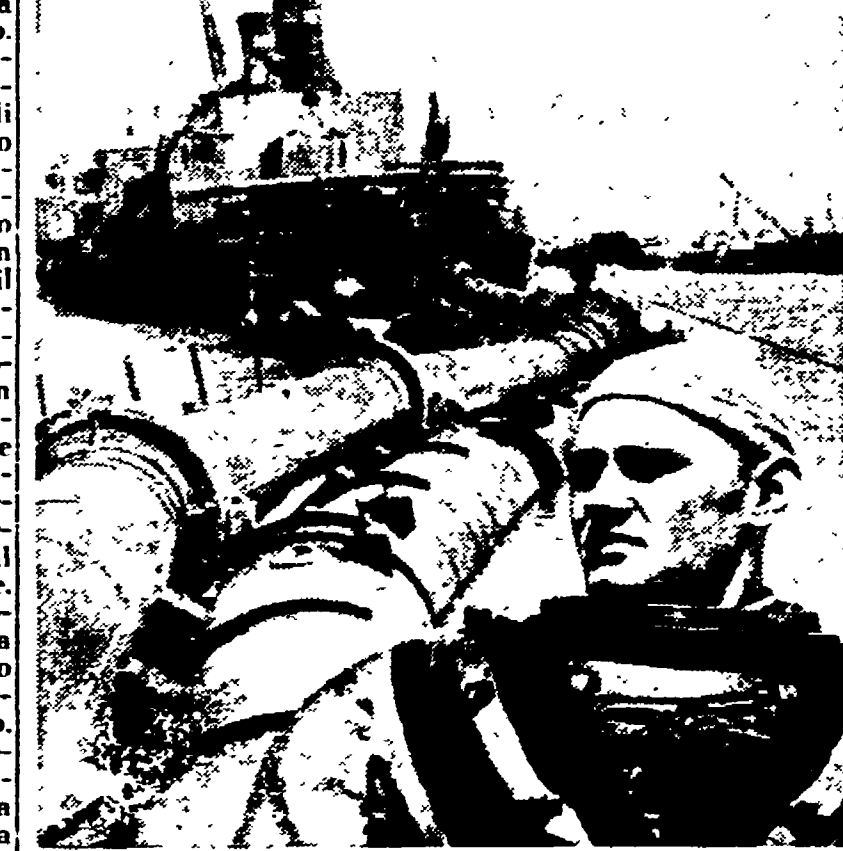
U.R.S.S. — Un aspetto dei lavori per la costruzione della centrale idroelettrica di Kakhovka. In primo piano, il palombaro Vladimir Ternovski
