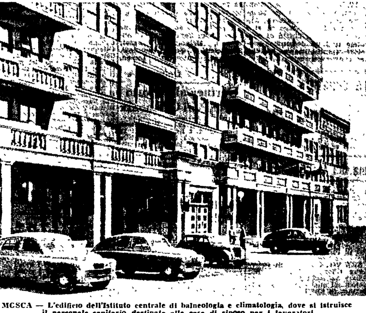
MOSCA — L'edificio dell'Istituto centrale di balneologia e climatologia, dove si istruisce il personale sanitario destinato alle case di riposo per i lavoratori.
