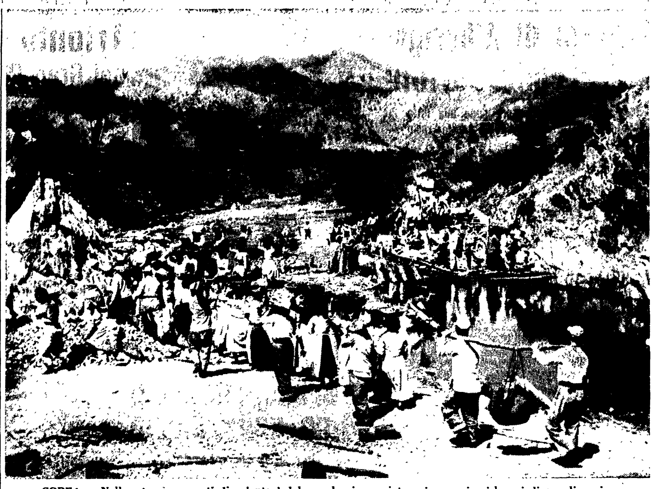
COREA — Nelle retrovie, reparti di volontari del popolo cinese aiutano i coreani nei lavori di canalizzazione
