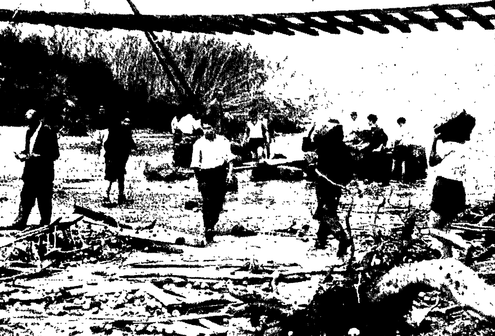
Il ponte ferroviario presso Oliveto (frazione di Reggio) è stato travolto dalla furia delle acque. Sono rimasti sospesi sul vuoto i binari. Operai sono al lavoro per le prime riparazioni. (Telefoto)
