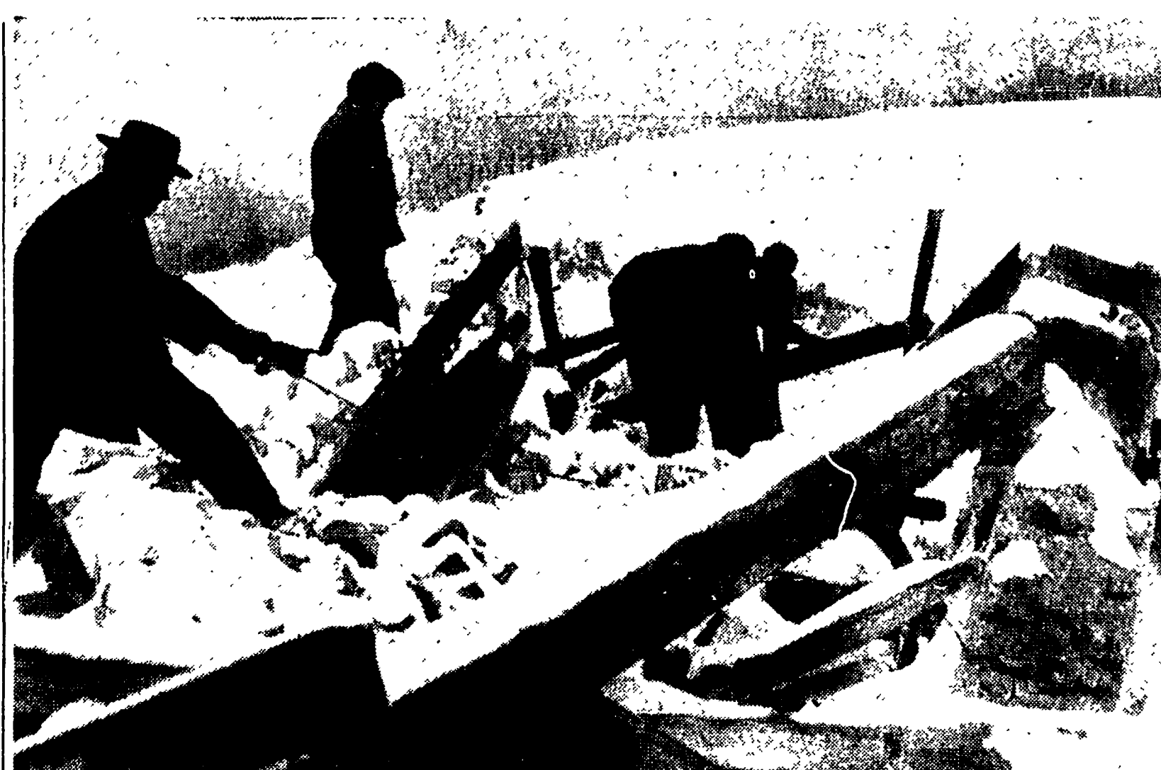
MISSANO DI ZOCCA (Modena) — Una delle case del piccolo abitato sull'Appennino modenese, investita e distrutta dalla frana di terra che cammina alla velocità di 60 centimetri all'ora...
