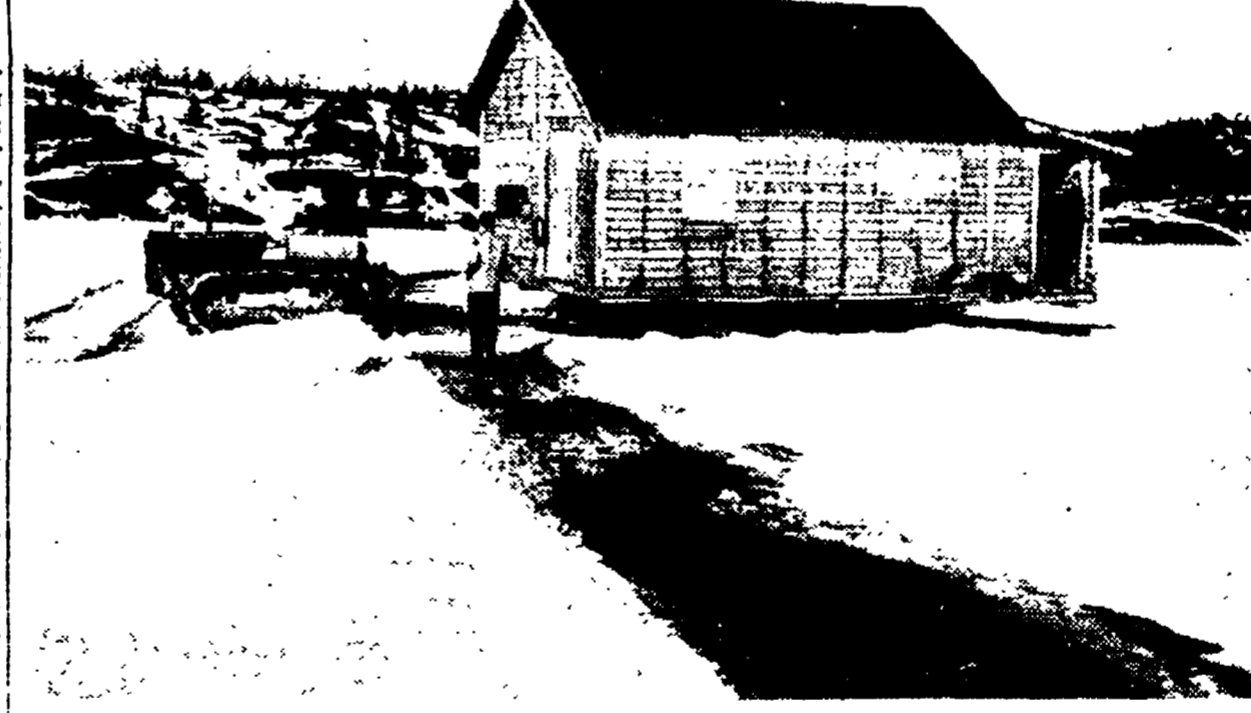
CANADA - Sulla strada già percorsa dai terroristi d'oro si muove una casa prefabbricata
