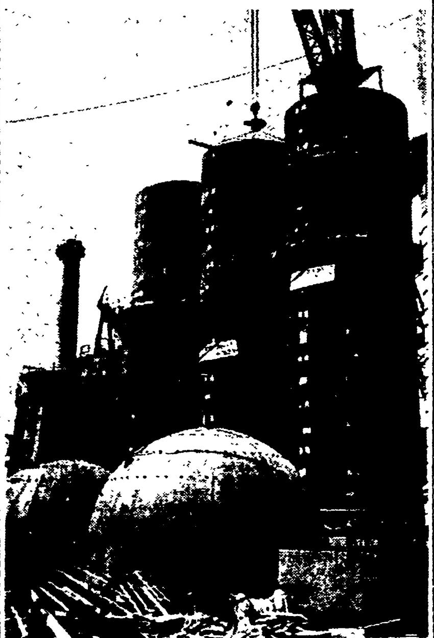
PCOLONIA — I giganteschi serbatoi del primo altoforno in funzione tra breve nelle Fonderie Lenin di Nowa Huta
