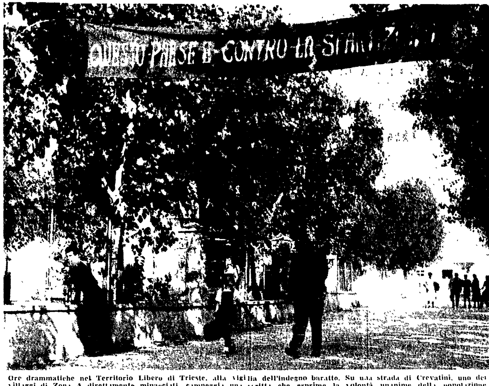
Ore drammatiche nel Territorio Libero di Trieste, alla Vigilia dell'indegno buratto. Su una strada di Crevatini, uno dei villaggi di Zona A direttamente minacciati, campeggia una scritta che esprime la volontà unanime della popolazione
