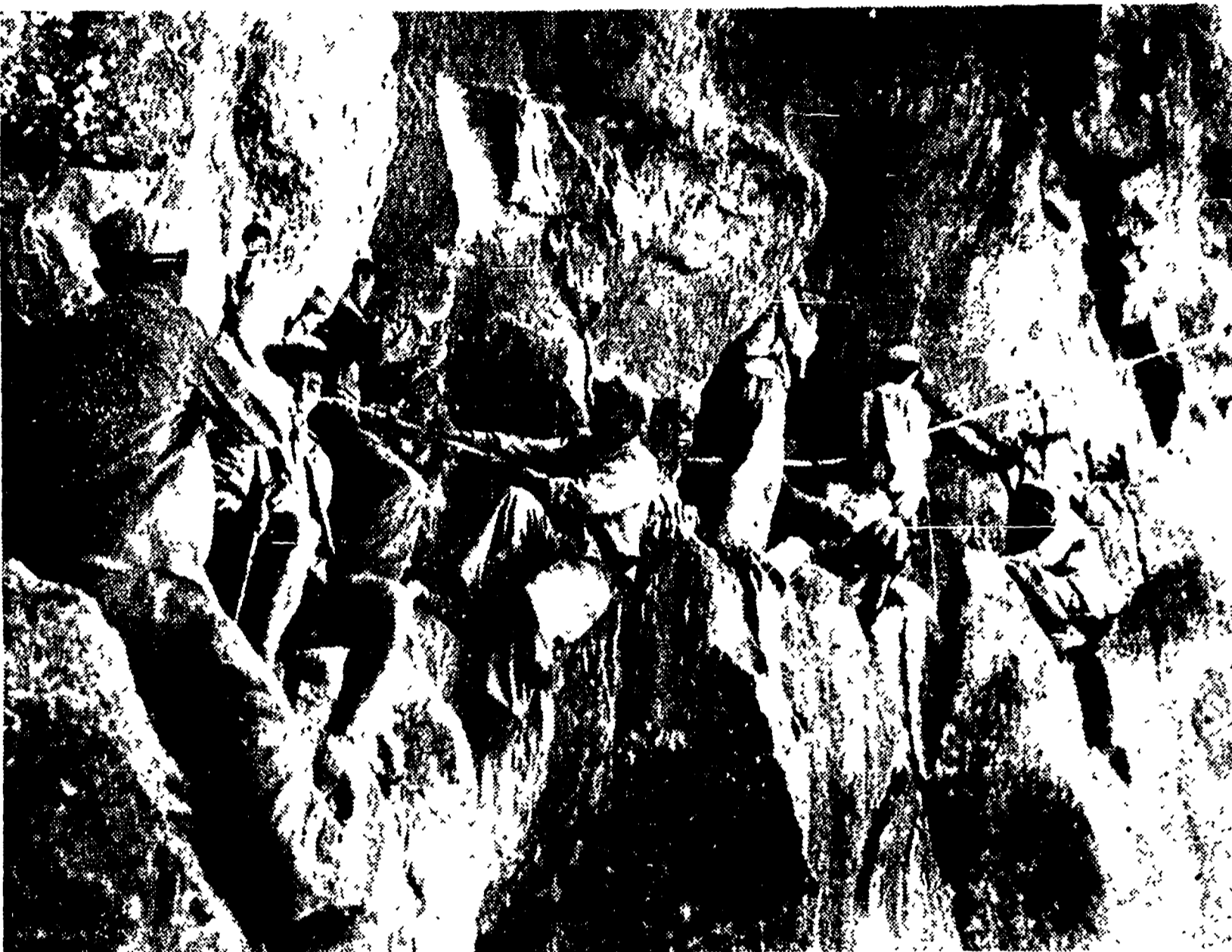
SI KANG — Un momento della costruzione della strada per il Tibet; un gruppo di operai scava fornelli per le mine, lavorando aggrappati alla parete di roccia a centinaia di metri dal suolo
