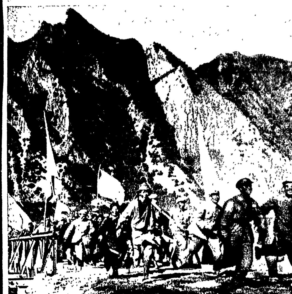
CINA - Un momento indimenticabile per i costruttori di una delle due strade che hanno collegato il Tibet alla Cina: l'incontro dei lavoratori che avevano iniziato la strada, lunga 2225 km., da est con quelli che provenivano dall'ovest
