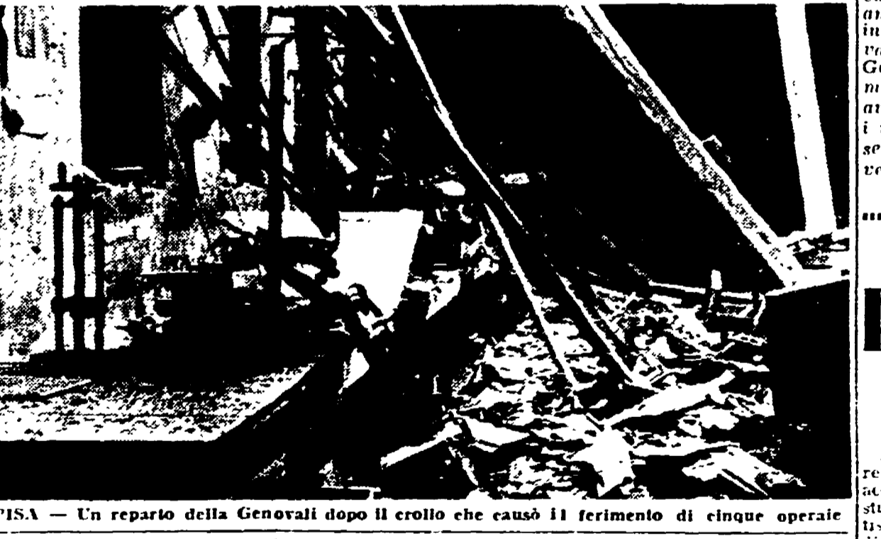
PISA — Un reparto della Genovale dopo il crollo che causò il ferimento di cinque operai
