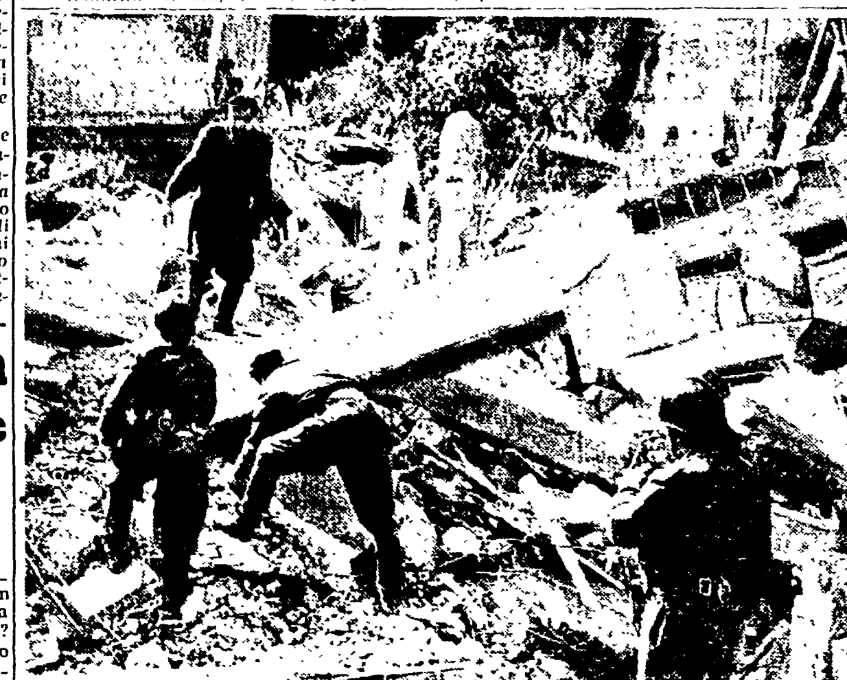
NAPOLI — Una visione dello spaventoso crollo
