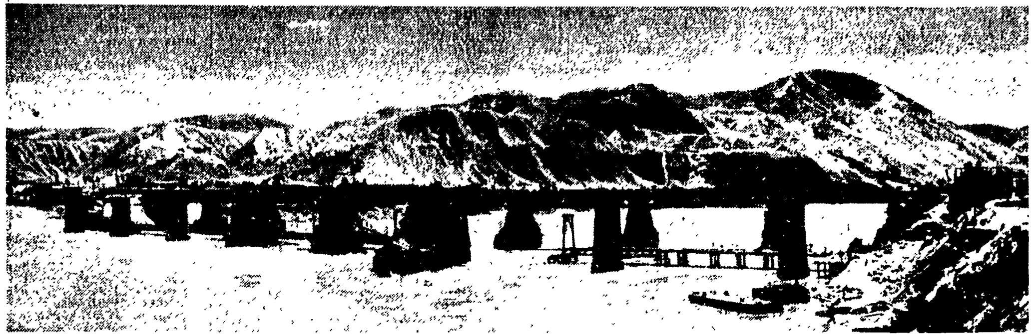
Sul Fiume Giallo si lavora già da tempo. NELLA FOTO: la costruzione di un ponte ferroviario che unirà il Kenseu al Sinkiang
