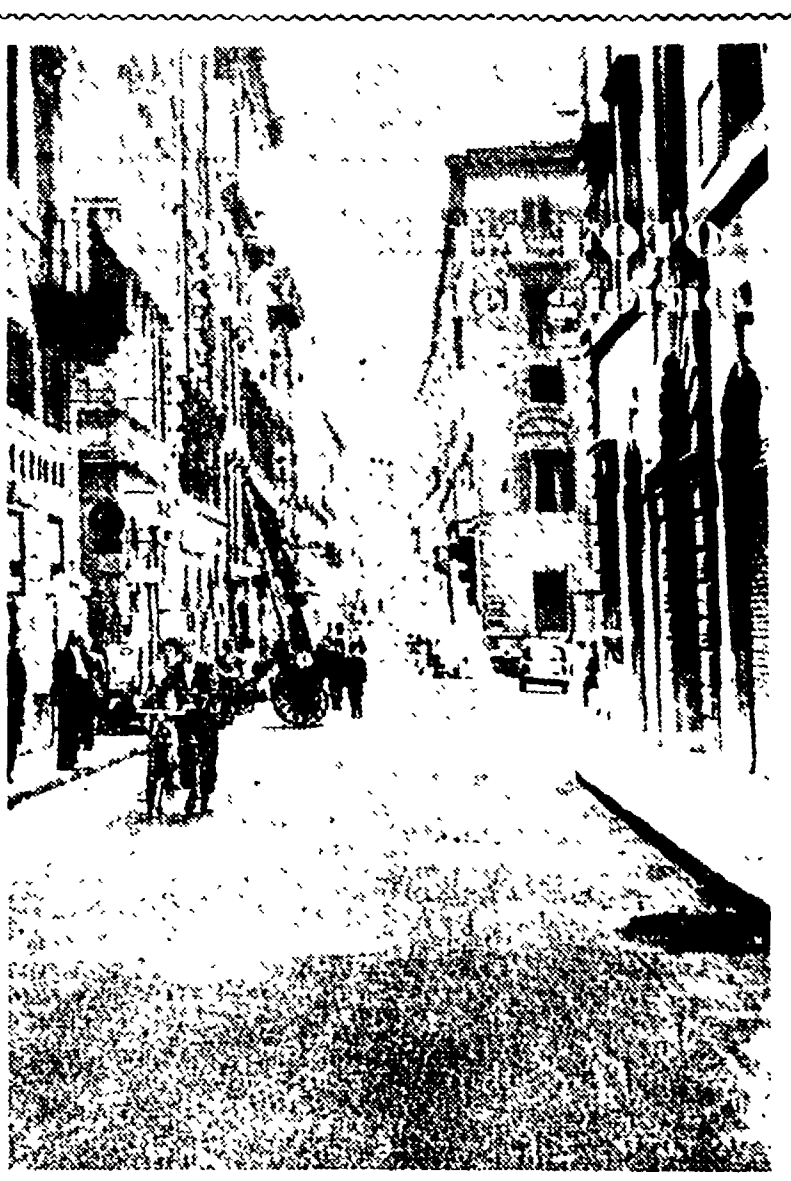
I lavori stradali di via della Mercede sono finalmente ultimati. Il traffico dei veicoli, compresi quelli dell'ATAC, obbligati a compiere un percorso fastidioso, sarà ristabilito a partire da domani.
