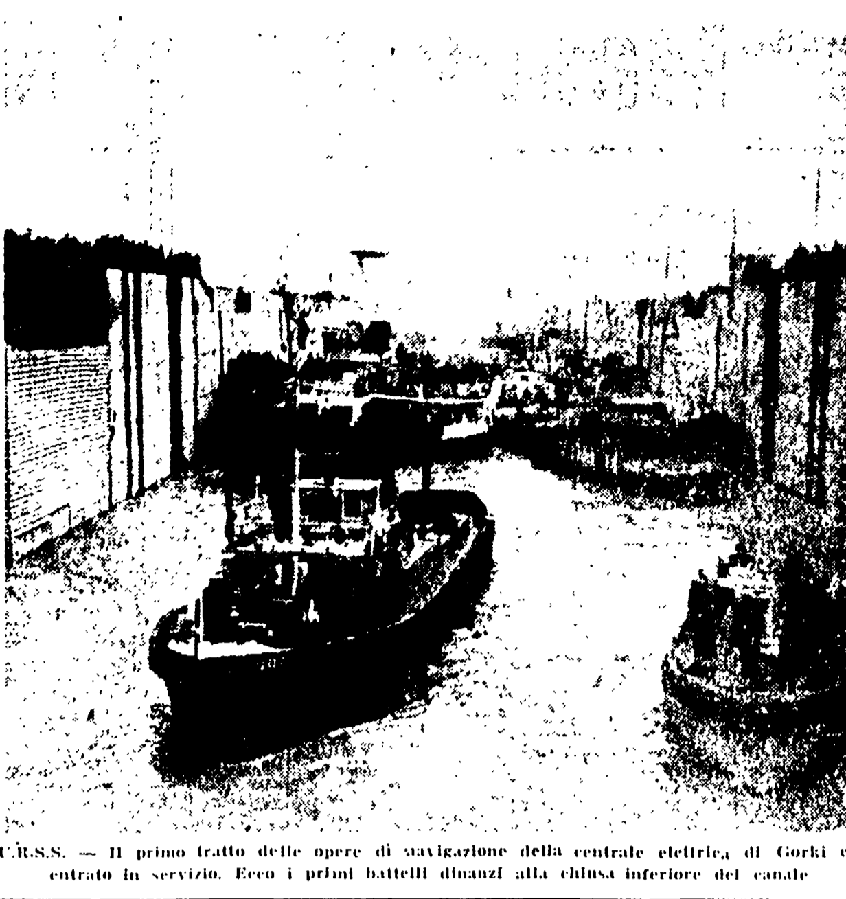
U.R.S.S. — Il primo tratto delle opere di navigazione della centrale elettrica di Gorki è entrato in servizio. Ecco i primi battelli dinanzi alla chiusa inferiore del canale
