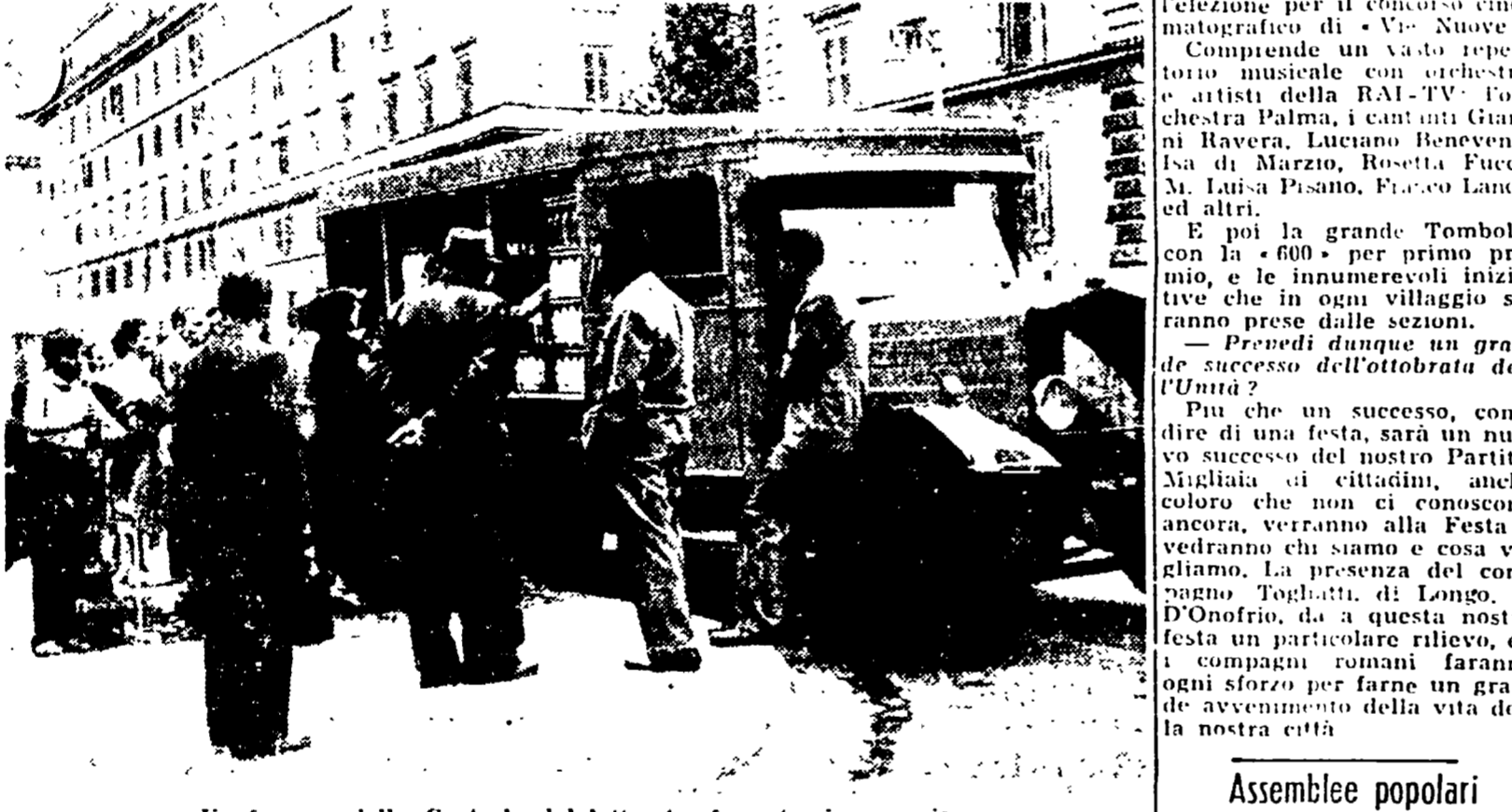
Un furgone della Centrale del latte trasformato in spazio
