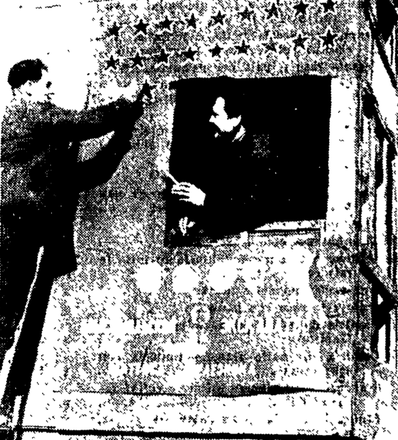
KUBINSKY — L'operaio elettromeccanico Samurayev dibegna sulla cabina dell'escavatrice la ventesima stella, che segna il primato di due milioni di metri cubi di terra estratti, durante i lavori di costruzione della centrale idroelettrica.
