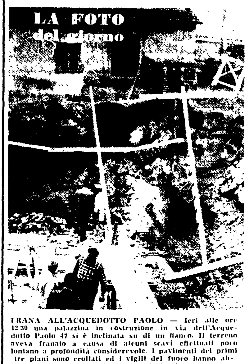
IRANA ALL'ACQUEDOTTO PAOLO - Ieri alle ore 12.30 una palazzina in costruzione in via dell'Acquedotto Paolo 47 si è inclinata su un fianco. Il terreno aveva frantumato a causa di alcuni scavi effettuati per la costruzione di un piano di assistenza. I palazzini dei primi tre piani sono crollati ed i vigili del fuoco hanno abbattuto i muri pericolanti.
