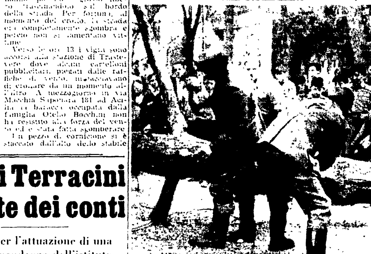
L'ALBERO CADUTO - I vigili del fuoco stanno liberando viale delle Medaglie d'Oro dal grosso pino abbattuto dal vento di ieri.
