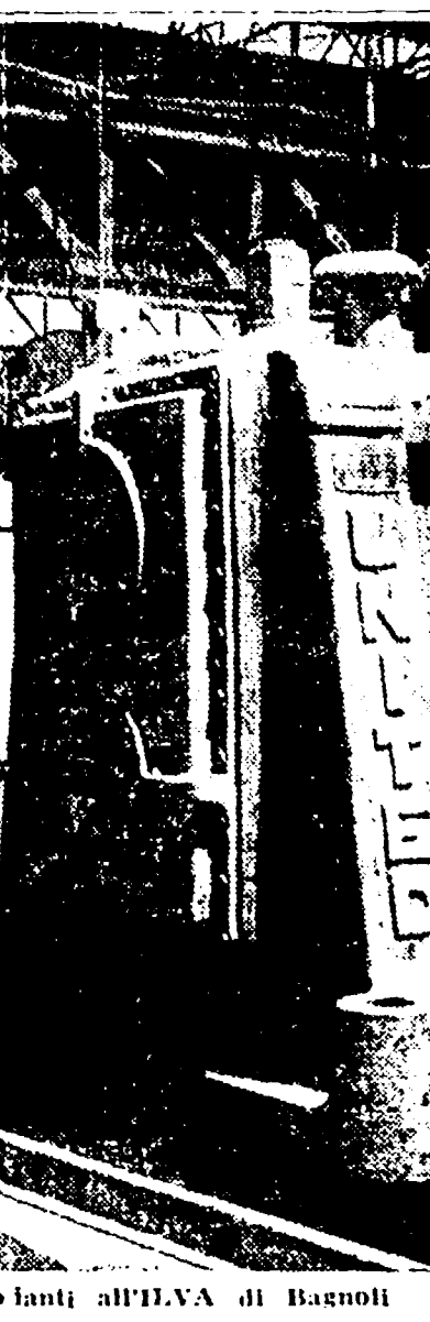
Messa in opera di nuovi impianti all'IVA di Bagnoli
