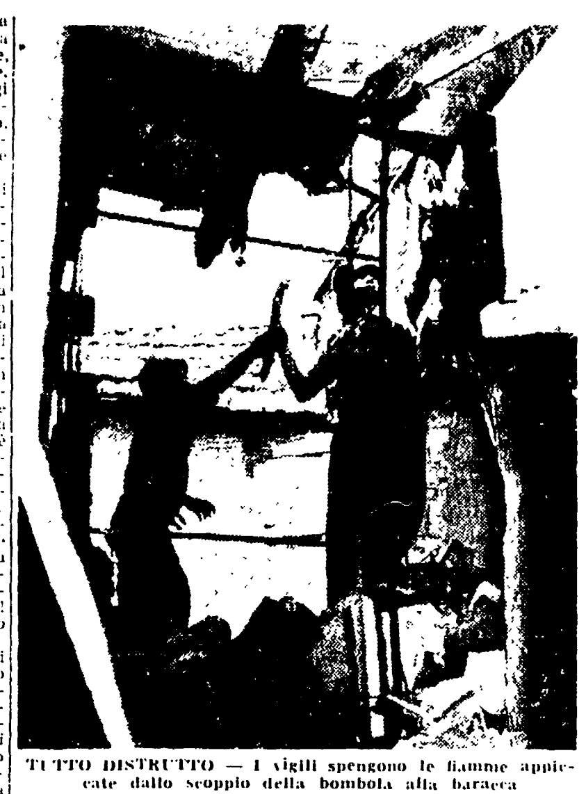
TITTO DISTRUTTO - I vigili spengono le fiamme appiccate dallo scoppio della bombola alla baracca
