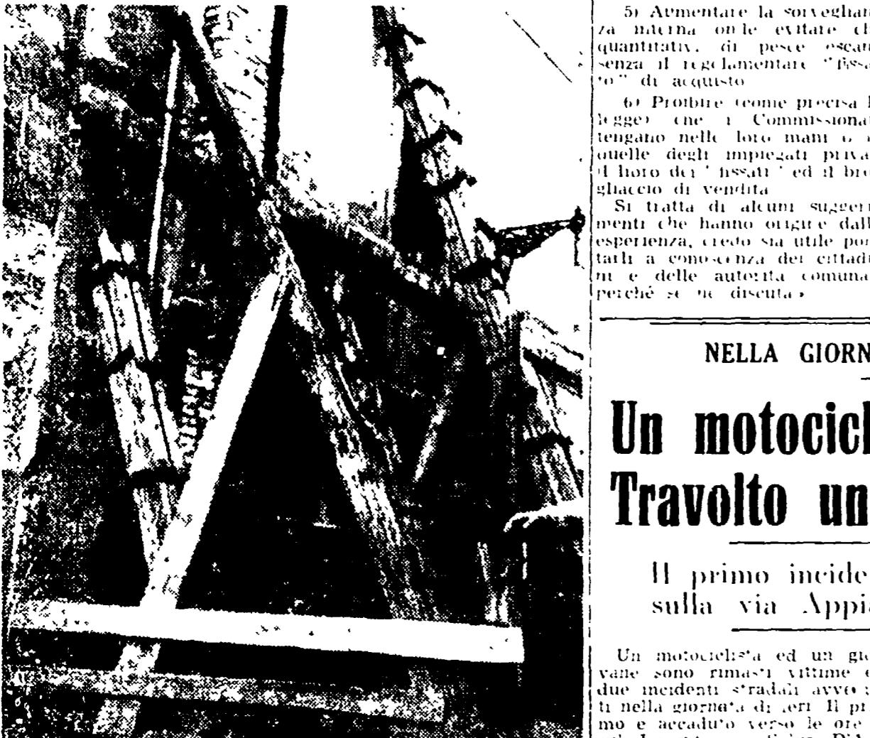
UNA CROLLATA — Nulla meglio di questa immagine può servire a testimoniare delle condizioni del fabbricato di via del Mattatoio dove diverse famiglie vivono da sei mesi sotto l'ineubito continuo di un crollo.
