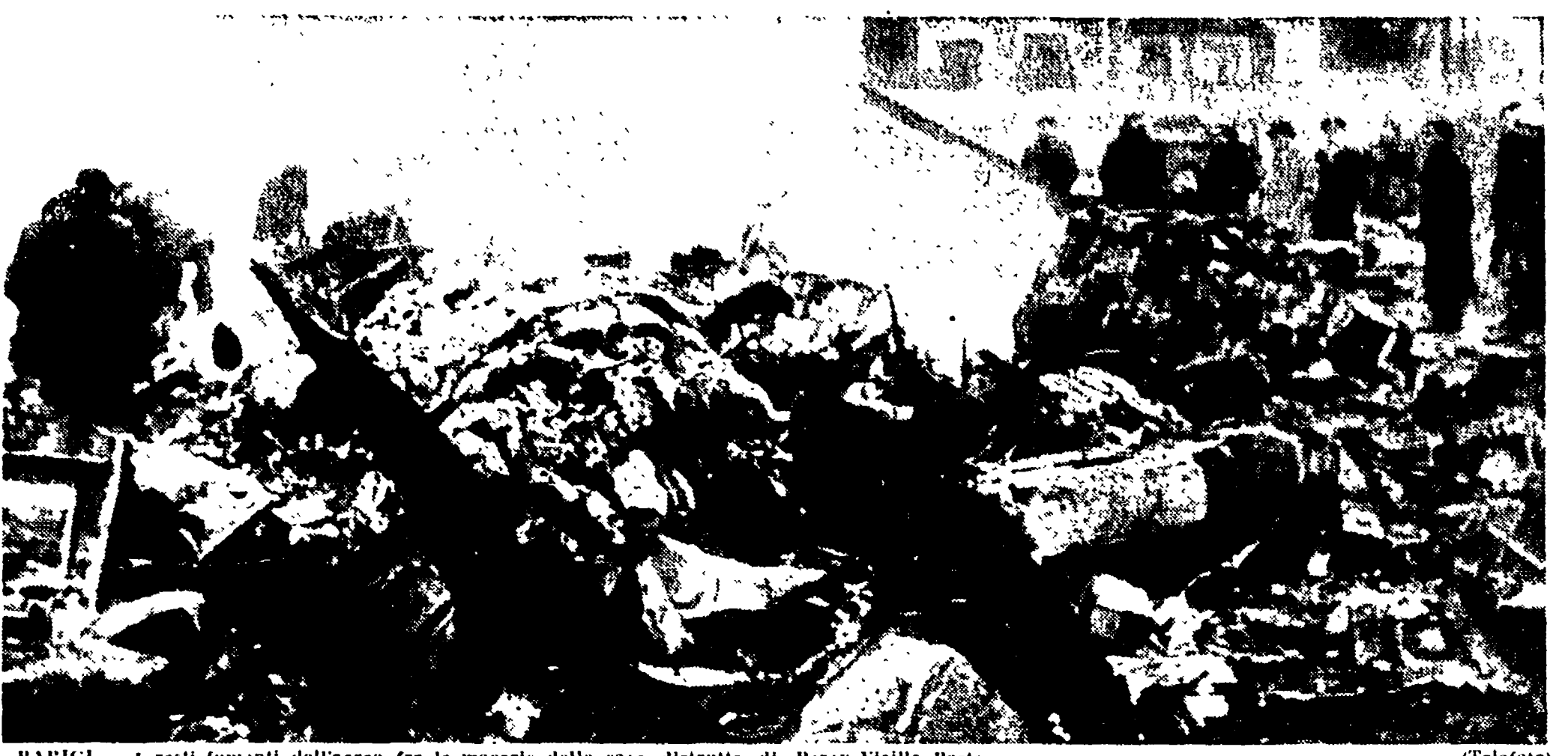
PARIGI - I resti fumanti dell'aereo tra le macerie delle case distrutte di Paray-Vieille-Poste
