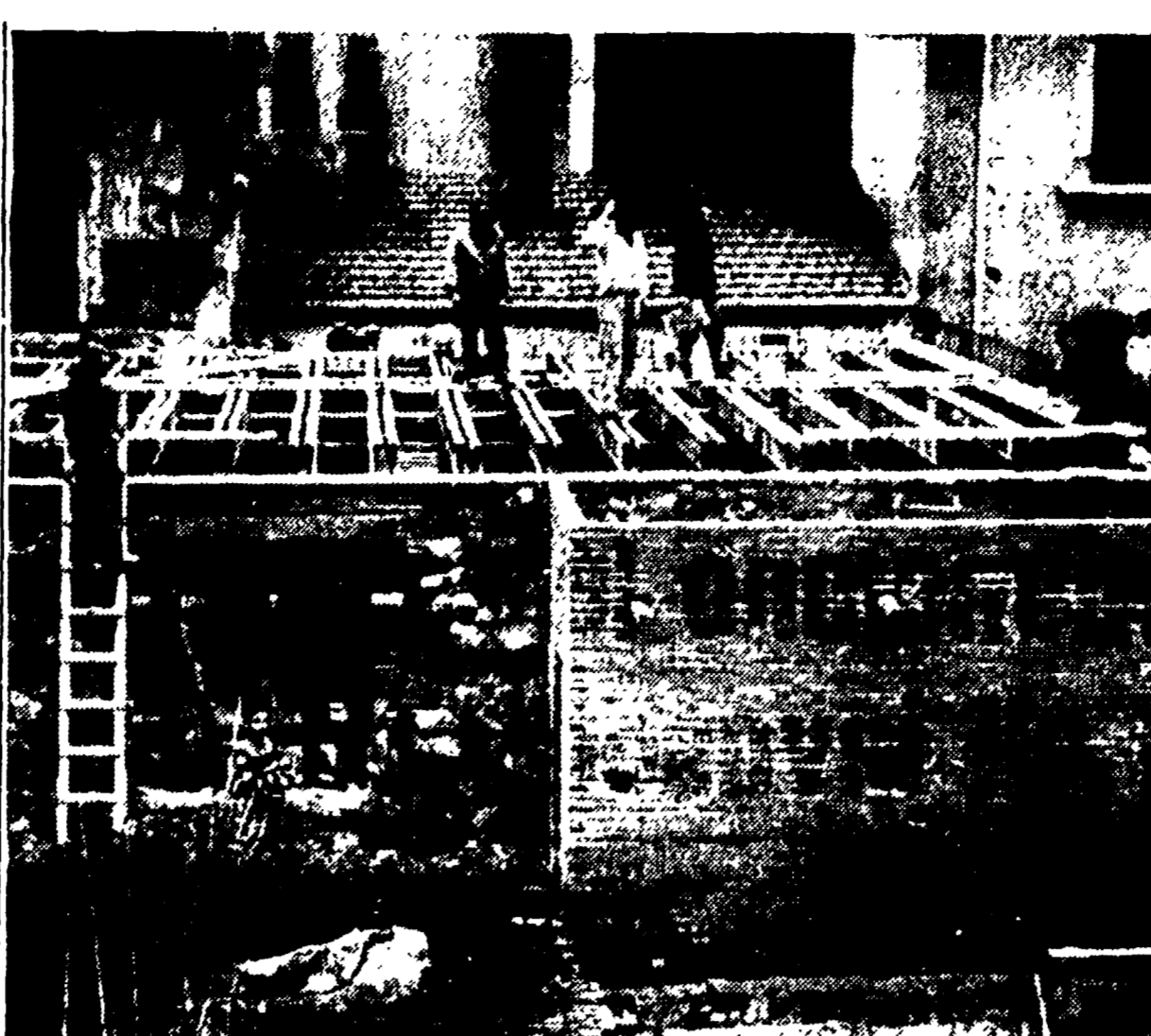
PISA — Sono in corso a Poria a Mare i lavori di ampliamento della Vecchia Casa del Popolo. Nella foto: si procede alla costruzione di un'ampia sala capace di ospitare alcune centinaia di persone
