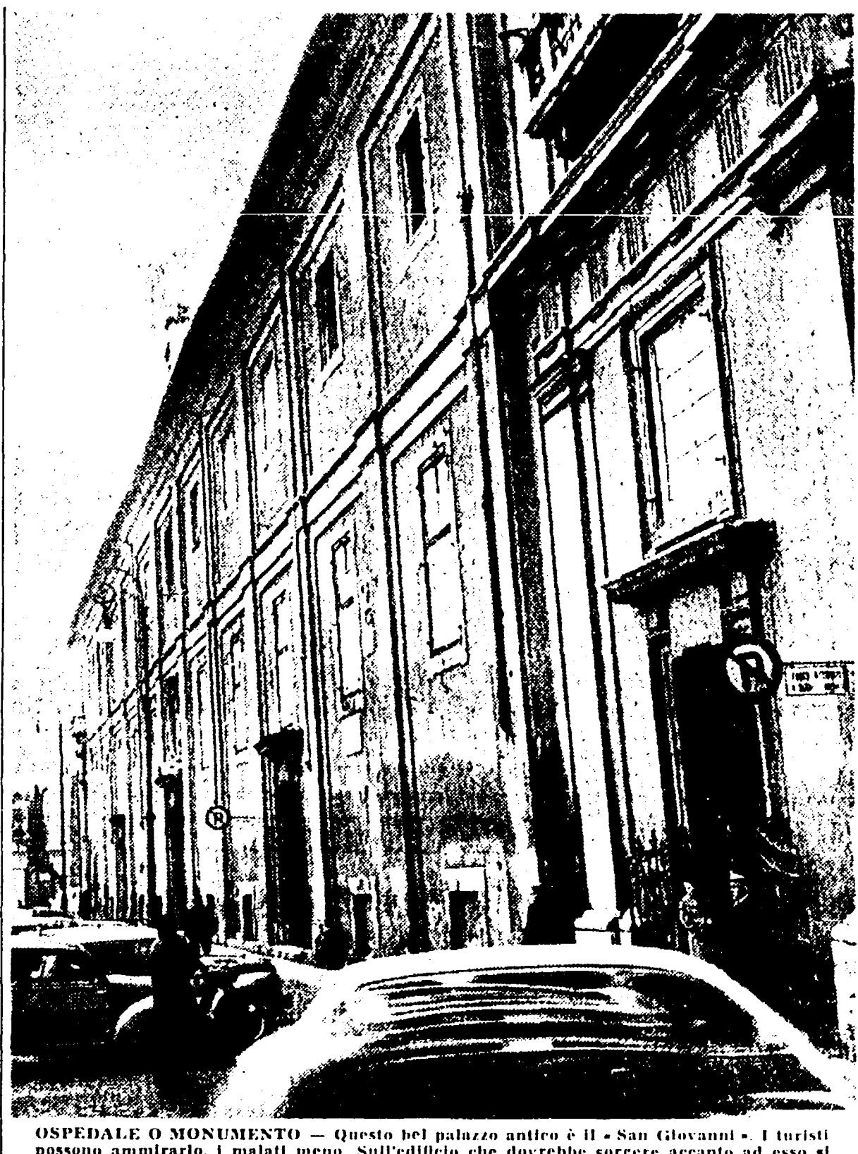
OSPEDALE O MONUMENTO — Questo bel palazzo antico è il San Giovanni. I turisti possono ammirarlo. I malati meno. Sull'edificio che dovrebbe sorgere accanto ad esso si svolge da anni una storia misteriosa.
